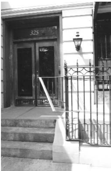
Une affaire récente, portée devant la Commission, a abouti à l'installation d'une rampe d'accès destinée à un locataire.
